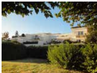
Façade sud de la Résidence 2000
